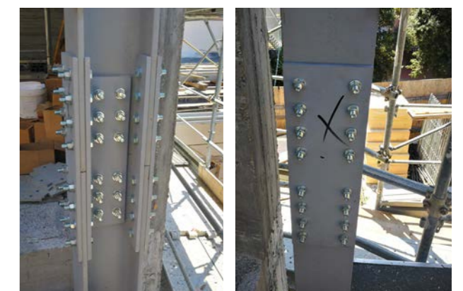
Particolari connessioni tra pilastri
