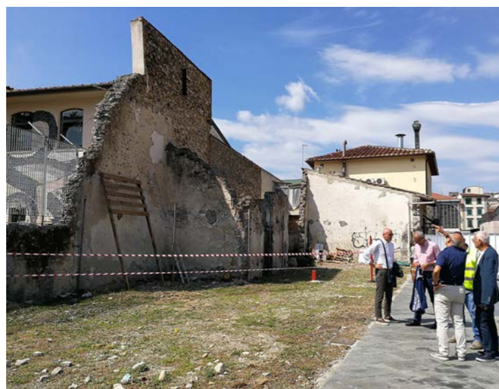
Situazione iniziale prima dei lavori
