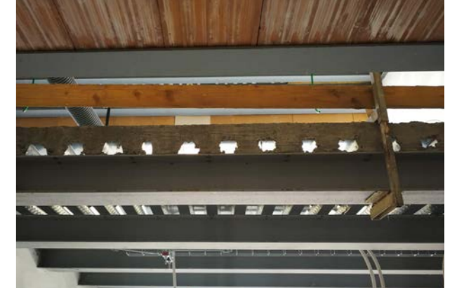
Dettaglio 4 - Solaio grecato
