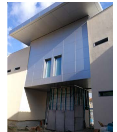
Montaggio dei rivestimenti
