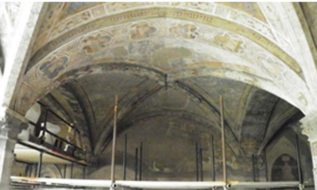
Cantiere di restauro delle volte
